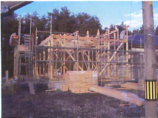
南三陸町歌津・吉野沢仮設集会所建設状況 すばらしい歌津をつくる協議会撮影 平成24年2月
